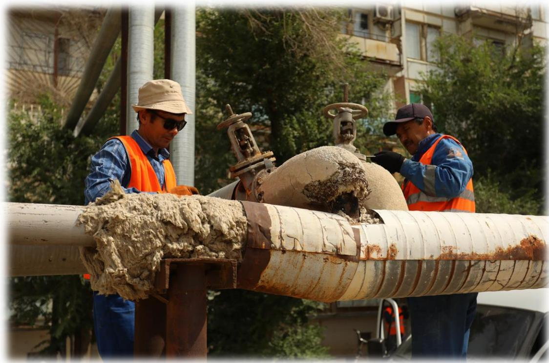
В рамках мероприятий по модернизации и поддержанию эксплуатационной готовности тепловых сетей проведена замена трубопроводов на отдельных участках общей протяженностью 5,5 метра. Также произведена замена одного отвода, пришедшего в негодность.
