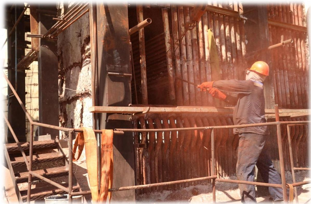
Дополнительно выполнены работы по демонтажу обмуровки холодной воронки, водоперепускных труб и коллектора. Продолжаются работы по демонтажу холодной воронки.
