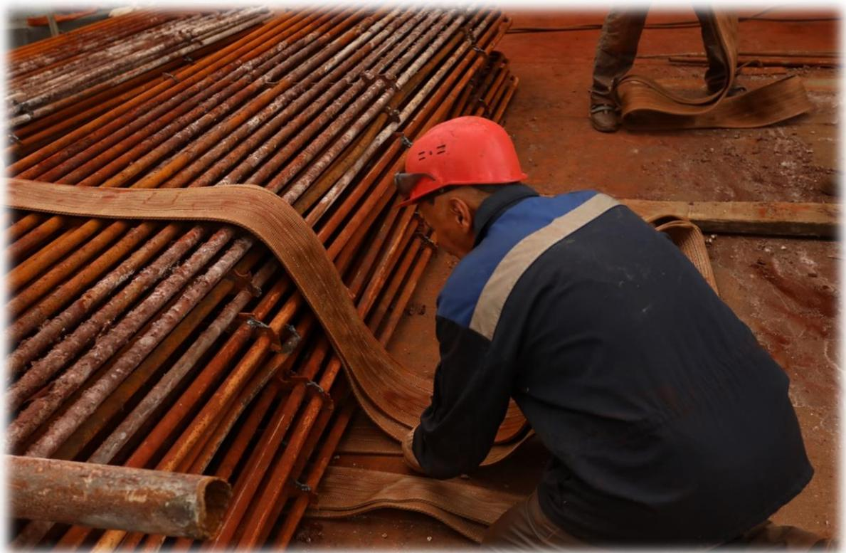
С 26 мая по 04 июня 2025 года осуществлён частичный демонтаж секций нижнего конвективного пакета в количестве – 51шт. Выполнен демонтаж старых секций с опусканием и выносом, а также подъём новых секций в количестве – 22шт., для выполнения монтажных работ.
